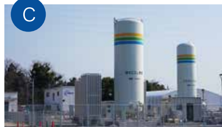
CO 2 供給設備
