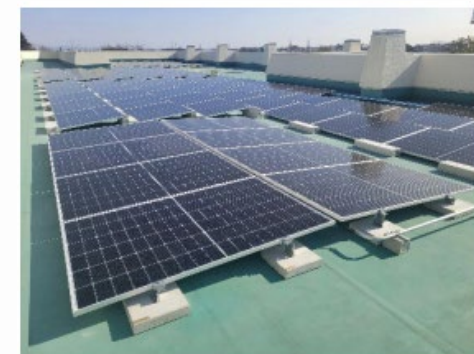
太陽光パネル基礎
