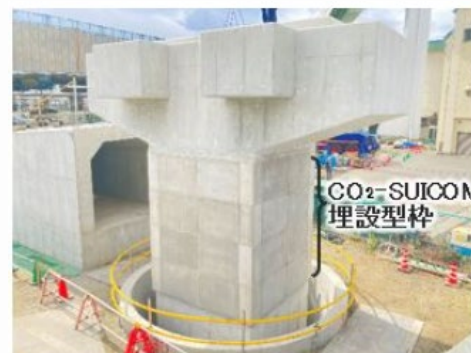
コンクリート型枠
